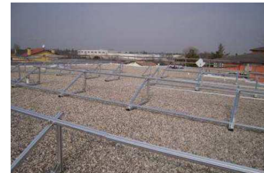
Foto 2: preparazione della copertura per l'installazione del fotovoltaico (2010)
